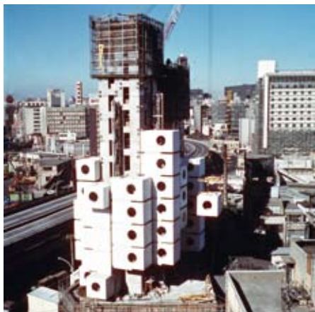
图3 东京中银胶囊大楼在建设中, 黑川纪章, 1972。大桥富夫摄影
