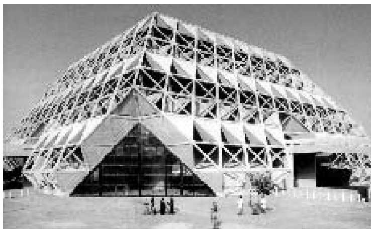
图6 新德里展览中心（建筑结构以几何网格的形式有规则地繁殖）（资料来源：邹德依，戴路 著. 印度现代建筑. 郑州：河南科学技术出版社，2003：7）
