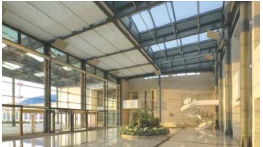
4 大堂主入口与点支玻璃幕墙，点支玻璃幕墙采用8F+12A+8F中空透明，钢化玻璃，既满足安全玻璃、自然采光，又可以降低传热系数，符合节能建筑的需要。
