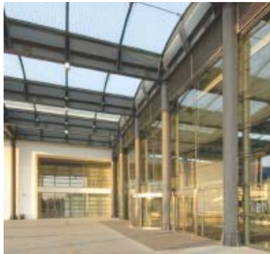
3 中空印刷采光LOW-E弯弧夹胶安全玻璃、灰色钢构、白色电动遮阳帘、浅黄色大理石、点支式玻璃墙，10米通高，围合成一个高大、明亮的大堂空间。
