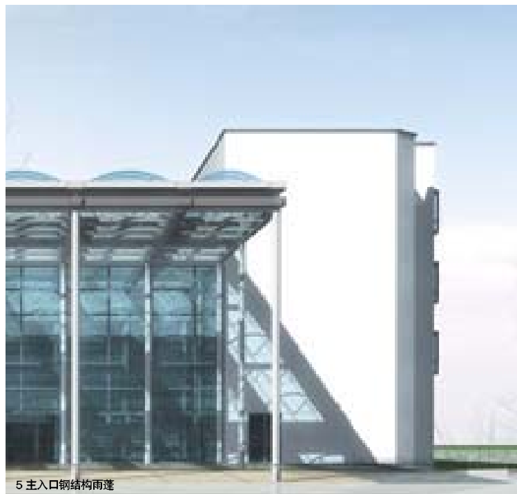
5 主入口钢结构雨篷
